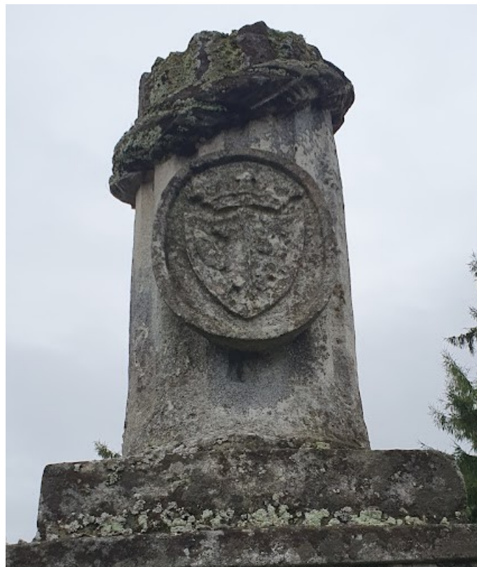
Fot. 10. Porażenie biologiczne w zwieńczeniu nagrobka.
