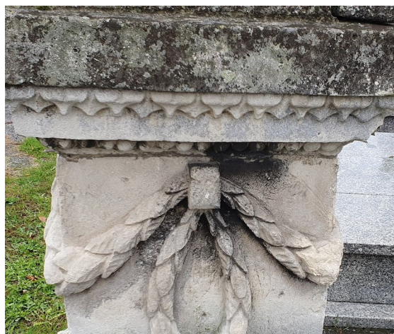
Fot. 6-8. Powierzchnia kamienia pokryta patyną.
