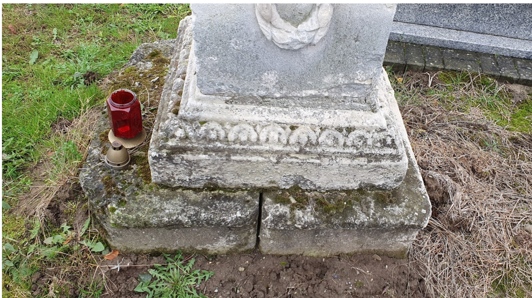
Fot. 19. Uszkodzenia mechaniczne – uszkodzony narożnik.
