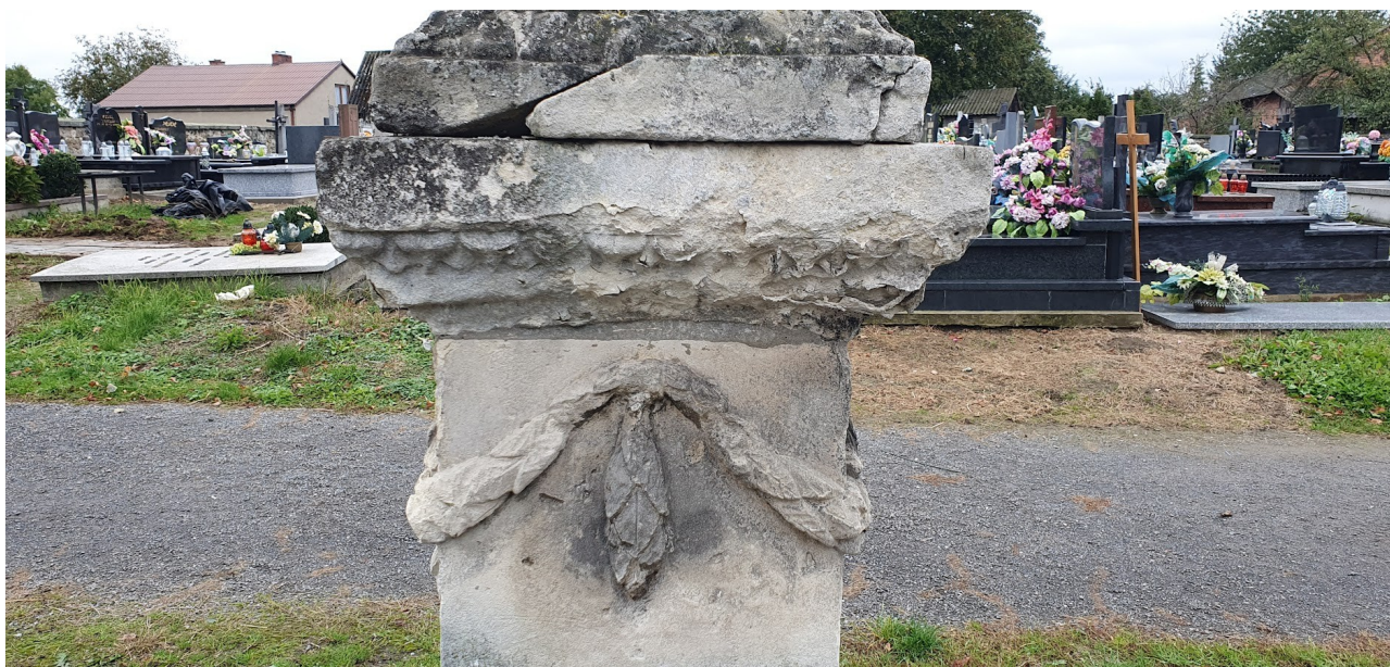
Fot. 12. Dezintegracja granularna kamienia.
