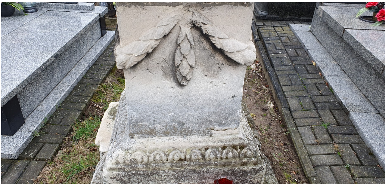
Fot. 11. Zatarcia formy rzeźbiarskiej wskutek wmywania i działania soli rozpuszczalnych w wodzie.
