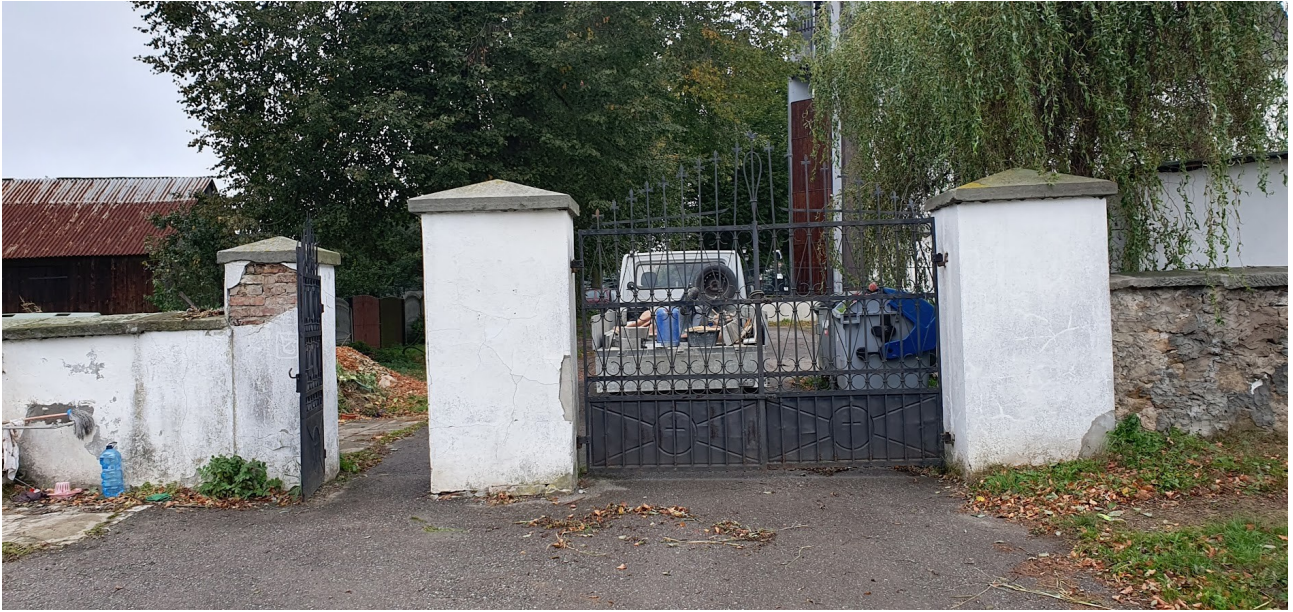
Fot. 2. Stan zachowania bramy wjazdowej na cmentarz – tył.
